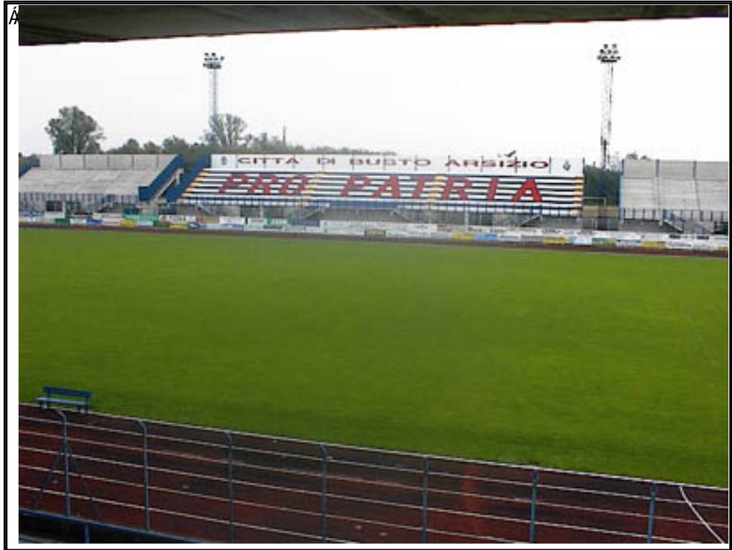
Ávista dalla tribuna centrale, dello stadio Carlo Speroni
